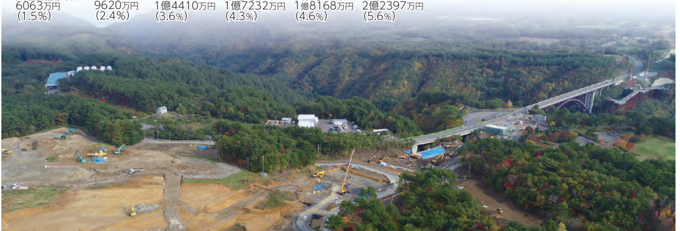
三陸沿岸道路の建設が進む思惟エリア周辺の様子（10月24日・ドローン撮影）
