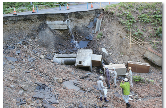
ハイペ線で工事の打ち合わせを行う応援職員の方
