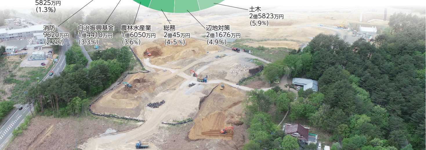
造成工事が進む新道の駅のはた建設地（5月13日・ドローン撮影）
