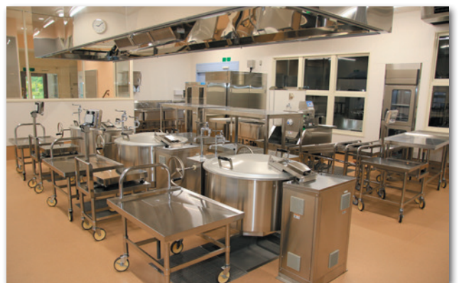
調理室には大釜を3台設置
