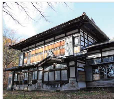
改修前の生きがいの館
