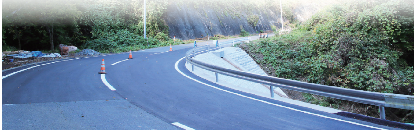
昨年10月の台風19号で崩落した村道ハイペ線の災害復旧工事 (10月21日撮影)
