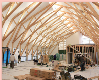
東側から見た内部(12月17日)
