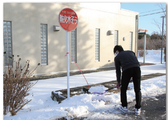
防火水槽のふたと標識をロープでつないでいます
