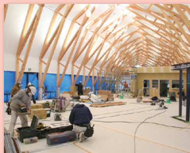
西側から見た内部(12月17日)
