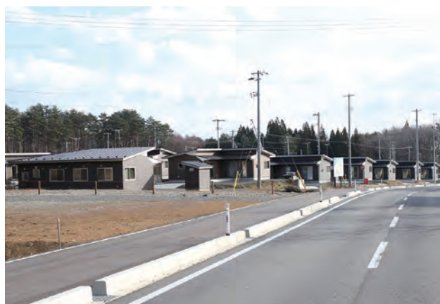
拓洋台団地内に災害公営住宅20戸完成(平成26年11月26日)
