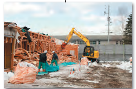
⑧アズビィ仮設住宅の解体工事の様子
