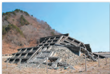
震災遺構「明戸海岸防潮堤」
