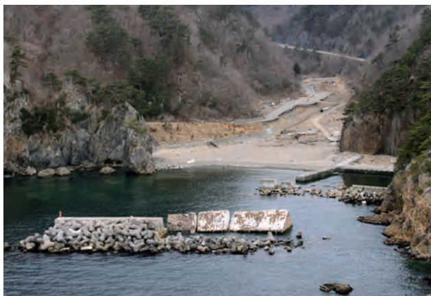
震災後の机浜。机沖防波堤が決壊し、机浜番屋群は流失
