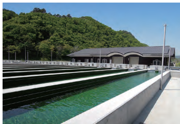
サケふ化場が完成(平成25年6月14日)
