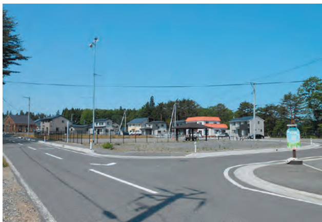
黎明台団地内に災害公営住宅24棟完成(平成26年7月31日)
