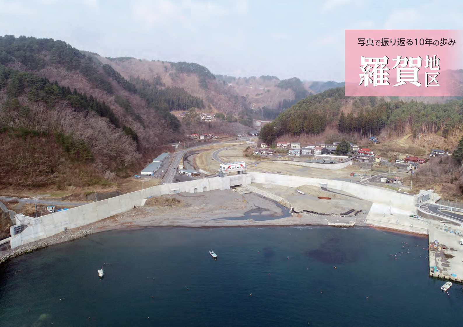
震災から10年が経過した羅賀地区。命を守る平井賀水門や高さ14.3mの防潮堤が完成
