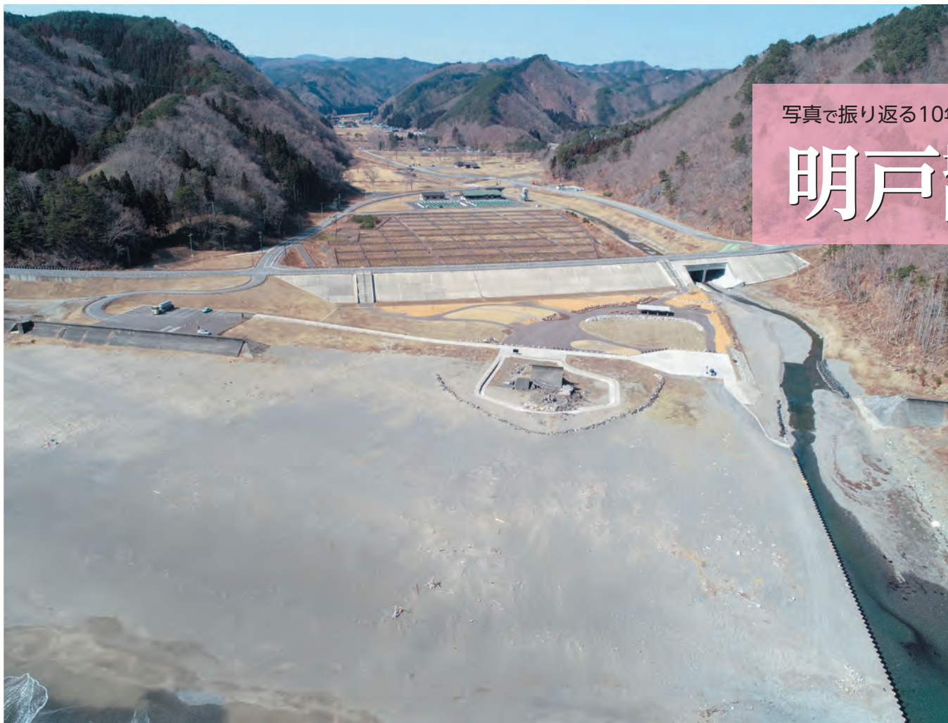
震災から10年が経過した明戸海岸。震災遺構やサケふ化場、マレットゴルフ場、キャンプ場が完成
