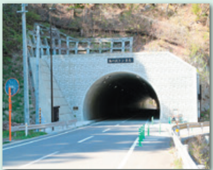
3月31日、島の沢トンネル開通
