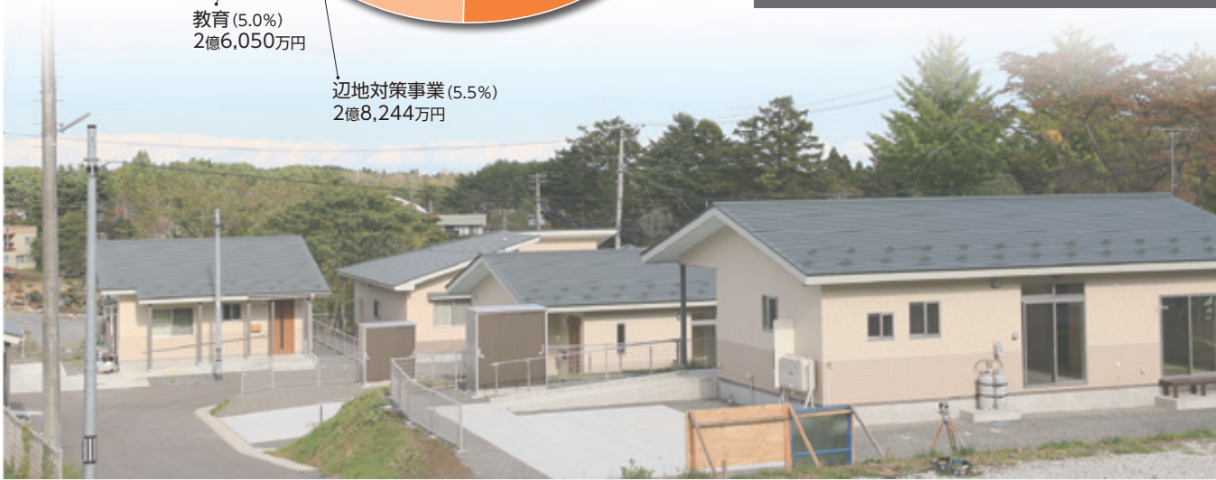
菅窪地区に整備した村営住宅（10月22日撮影）
