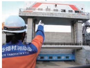
3月9日 平井賀水門が完成。消防団員などが遠隔操作や運用の方法を学ぶ
