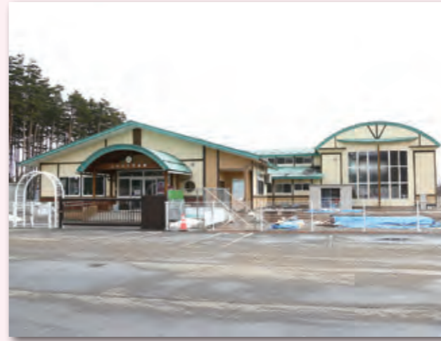
たのはたこども園の開園に向けて工事が進む(3月2日撮影)
