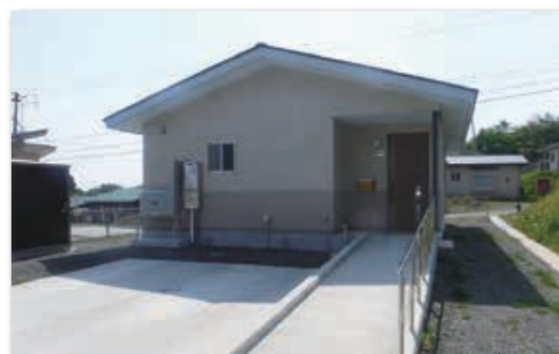
菅窪団地11号棟 (村営住宅)
