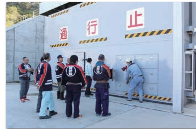
島の越水門や陸閘の操作方法を確認する村消防団第2分団1部の団員
