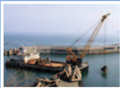
漁港施設内の海底に沈む消波ブロックや車の撤去作業も進んでいる（3月31日）
