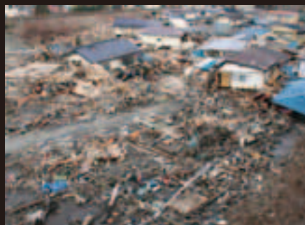
1階を破壊され2階部分だけの住宅も
