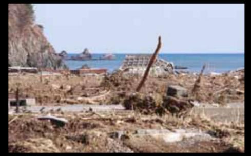
防潮堤は津波を完全に防ぐことはできない (津波で破壊された明戸浜の防潮堤)
