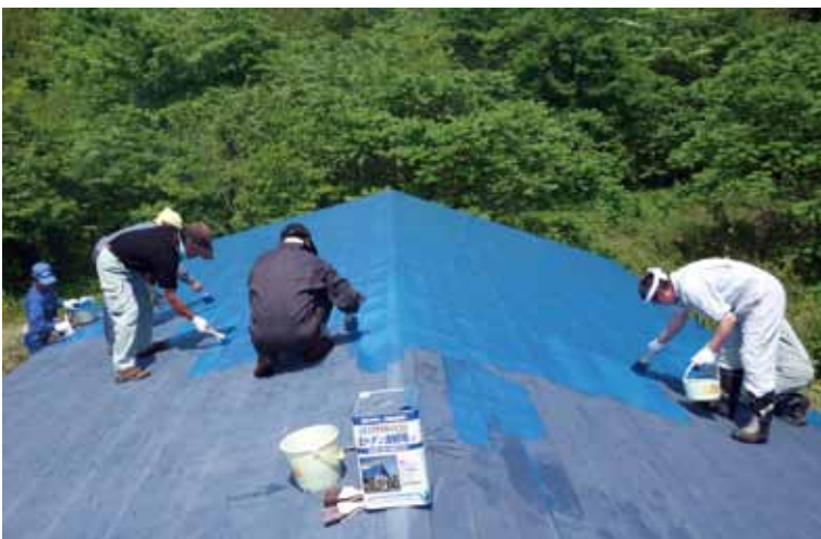
屋根の塗装作業に精を出す七滝地区の皆さん
